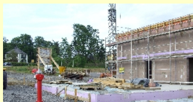
Wir sind nicht überrascht! Der Neubau des Feuerwehrhauses in Kürrenberg wird wesentlich teurer als geplant.
